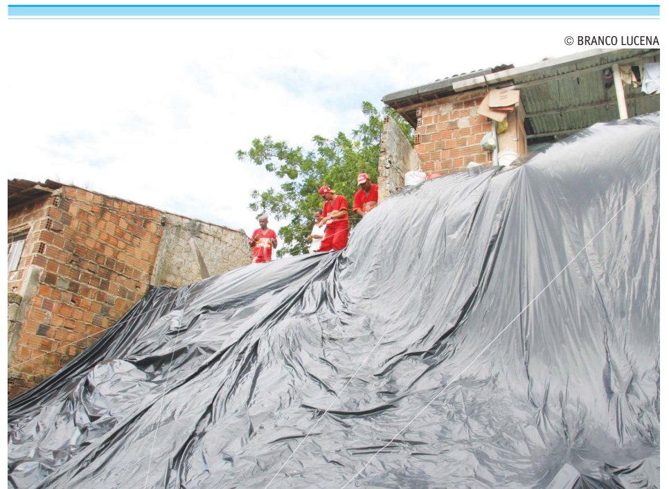
Encosta de bairro é coberto com lona de plástico para evitar erosão causada pela chuva
